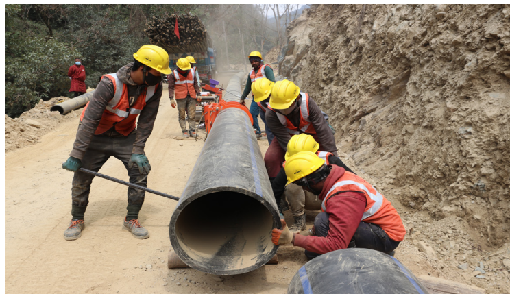
Рабочие в Бутане устанавливают систему принудительного орошения, модернизированную с использованием новых климатоустойчивых технологий, чтобы справиться с дефицитом воды в Пханджиуле. Эта новая система обеспечит орошение более 1300 акров сельскохозяйственных земель, принадлежащих жителям 24 сел.
