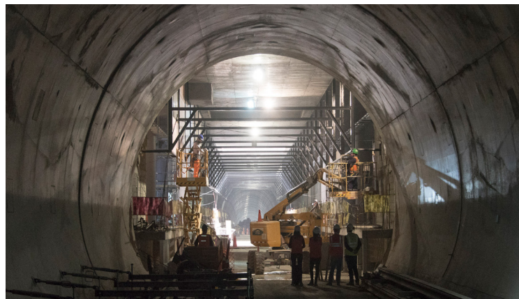
В Лиме, Перу, идет строительства туннеля и станции метрополитена — более безопасной и экологичной транспортной системы.
