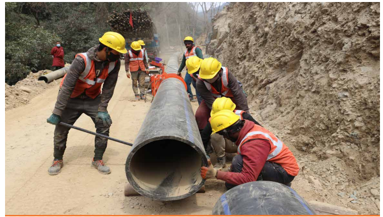
Au Bhoutan, des travailleurs répondent à la pénurie d'eau de Phangyul en installant un système d'irrigation sous pression, adapté grâce à une nouvelle technologie résiliente au climat. Le nouveau système desservira 24 villages et plus de 1 300 acres de terres agricoles.
