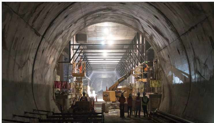
在秘鲁利马，一个 可提供更安全和更可持续的交通系统的地铁线上的隧道和车站正在建设中。
